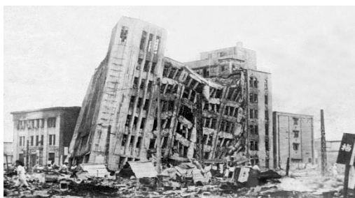
福井地震で倒壊した大和デパートビル
